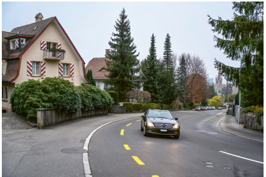
Zugerbergstrasse: Quartierstrasse, übergeordnet, Lage am Hang. (Bild AB)
