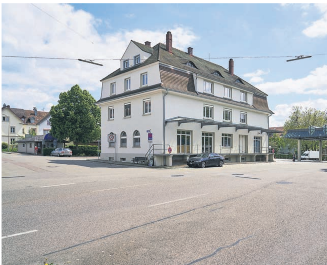
Hinter dem Zollgebäude auf Lörracher Seite soll die neue S-Bahn-Station entstehen. Sie soll als Mobilitätsdrehscheibe für das ganze Grenzgebiet dienen.
