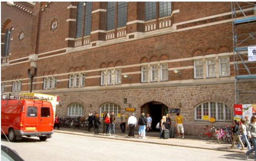
Abbildung 28: Hauptbahnhof Kopenhagen, Hauptzugang Vesterbro-Seite: Zugänge sind klein und kaum auffindbar. Ausserdem fehlt Platz für die Fussgänger.
