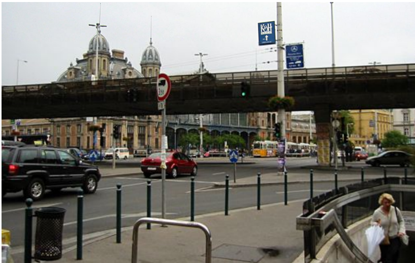
Abbildung 27: Budapest: Zugang zum Bahnhof ist nur indirekt durch die Unterführungen möglich. Ausserdem stört eine Verkehrsbrücke den visuellen Bezug.
