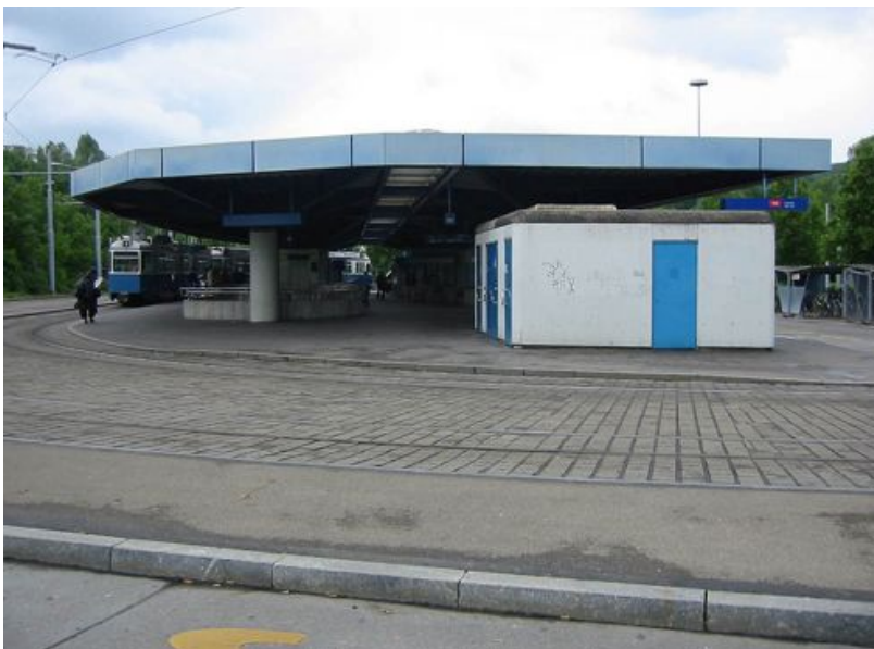
Abbildung 26: Bahnhof Zürich- Stettbach vor der Sanierung: Keine gemütliche „Wohnzimmeratmo- sphäre“ (Foto Metron)
