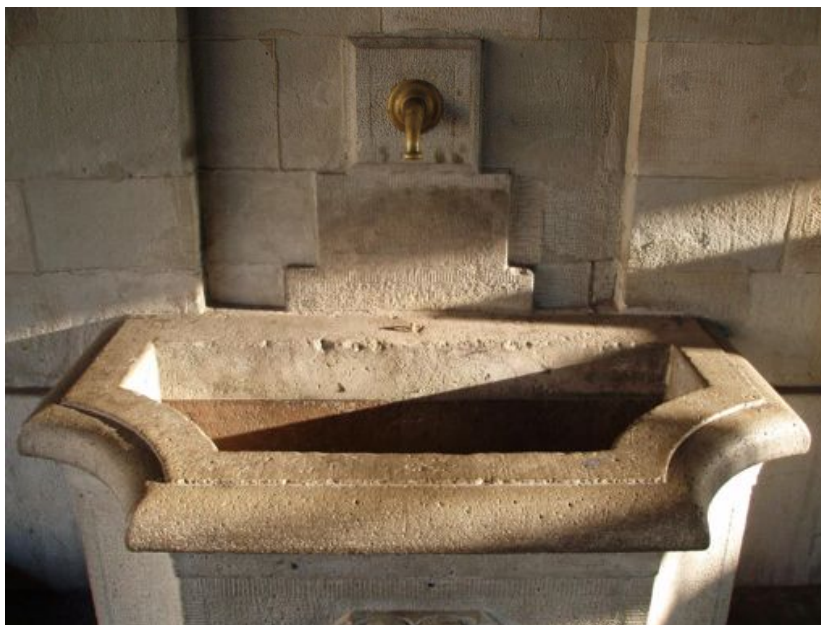
Abbildung 30: Der stillgelegte Trinkwasserbrunnen beim Bahnhof Brugg.
