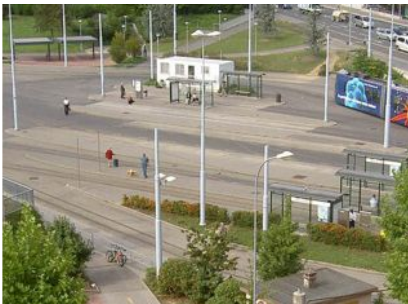
Abbildung 36: Tramknoten Genève Bachet als Betonfläche: Bus- und Tramstationen bekommen im Allgemeinen wenig gestalterische Aufmerksamkeit.
