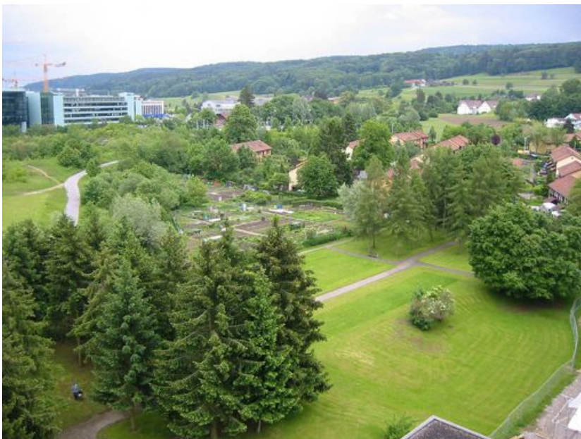
Abbildung 29: Versteckt im Grünen befindet sich der periphere städtische Umsteigepunkt Zürich-Stettbach. Der unübersichtliche Zugang und das Fehlen von Sichtkontakt zwischen Umsteigepunkt und umliegenden Wohngebäuden verstärken das Unsicherheitsgefühl. (Foto Metron)
