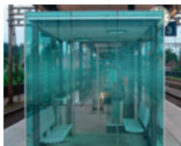
Bahnhaltestelle Muri AG: langes Perrondach und Wartehäuschen mit Sitzgelegenheit
